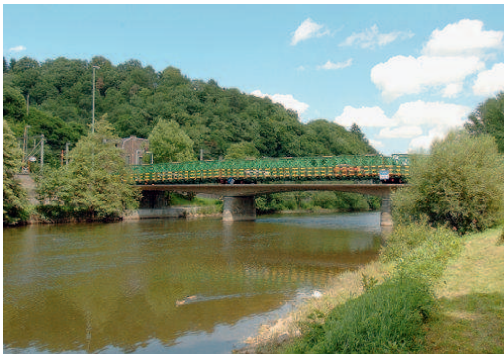
Le pont provisoire vit-il ses dernières heures ? Seule certitude : le débat sur son remplacement n'est pas fini.
