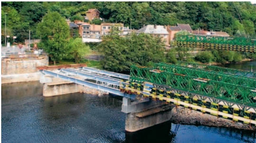
C'était en 2005, l'armée installait un pont provisoire sur l'Ourthe. 5 ans après, il est toujours là. ■ S.P.
